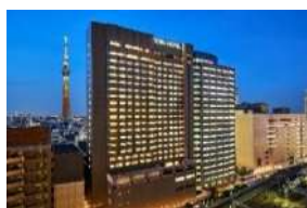
東武ホテルレバント東京 外観
